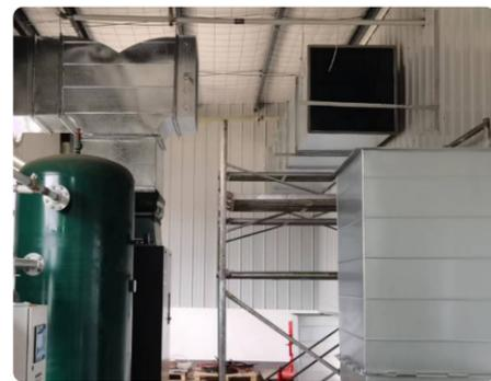
增加管道将空压机热气排口与成型室连接
